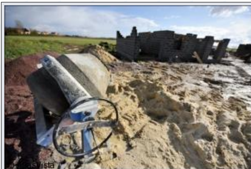
Chantier de construction, le 28 octobre 2008 à Courseulles-sur-Mer (© AFP/Archives - Mychele Daniau)
