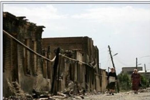
Des maisons détruites à Tskhinvali en Ossétie du Sud, le 16 août 2008 (© AFP - Dmitry Kostyukov)
